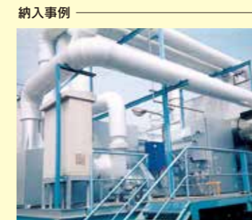
用途：半導体排気 風量：900Nm 3 /min
