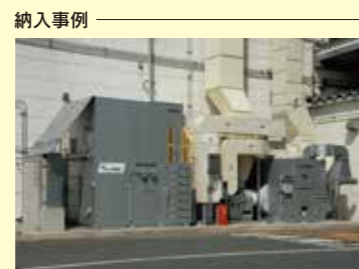
用途：電子部品製造排気 風量：220Nm 3 /min
