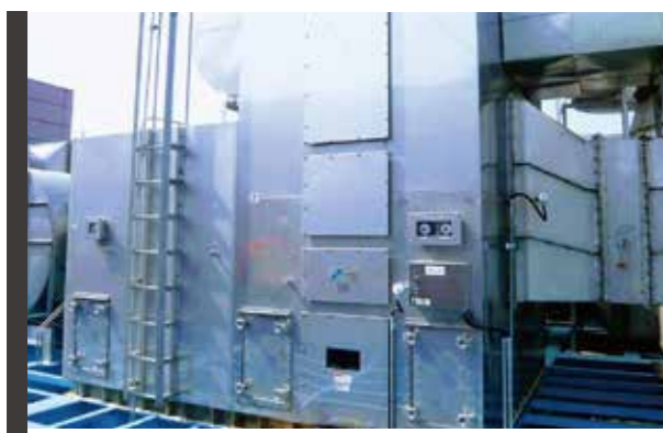
VOC濃縮ユニット(活性炭フィルターユニット付属) (VMU-3250V40-HF) 風量：50,000m³/hr VOC：PGMEA、IPA、etc. 納入先：半導体工場
